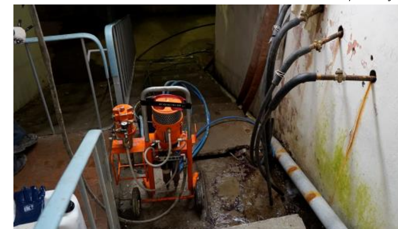
Рис. 3. Инъецирование шва А0 с лестничного марша
